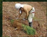
植栽 苗木を一定の間隔で植える作業です。保護カバーや獣害ネットを付けることがあります。
