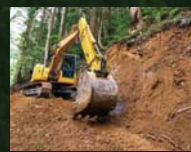
作業道開設 伐採した木を丸太にして搬出するため、山に道をつくります。幅は3m程度の道で、主に土のみで道づくりを行います。
